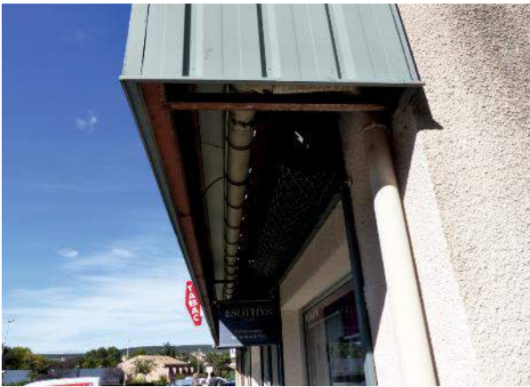
Caisson cache volet roulant
